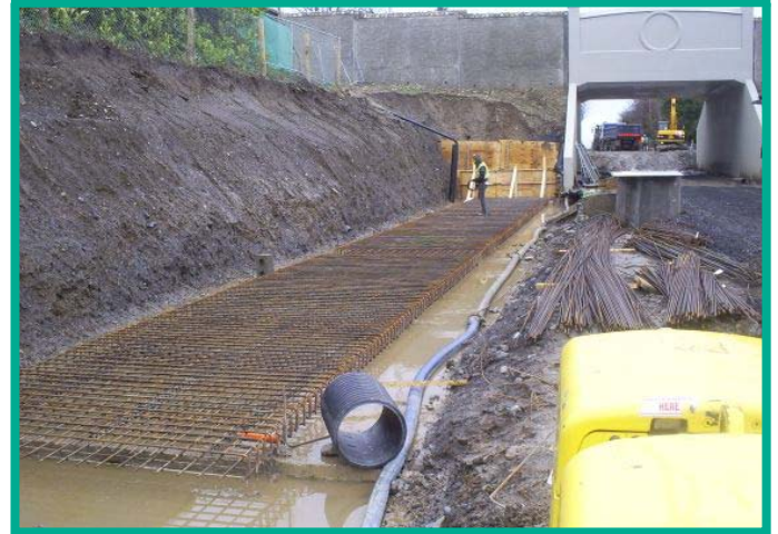
Plinth pour at Glenamuck Bridge
